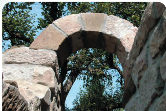
■ Vegetationsfläche frisch eingesät ■ Bogen und Ruinenmauer mit integriertem Sitzplatz aus handgeschlagenen Sandsteinblöcken
