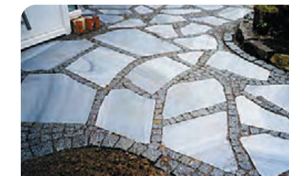
■ Kombination Wachhauer Kristallin polygonal Platten mit Bayerischem Granitpflaster
