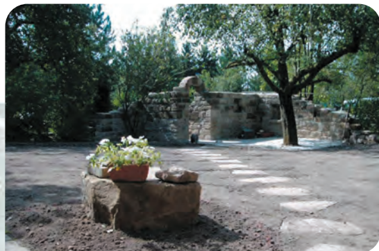
■ Vegetationsfläche frisch eingesät ■ Bogen und Ruinenmauer mit integriertem Sitzplatz aus handgeschlagenen Sandsteinblöcken
