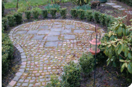
■ Kleine Gartennischen-Kombination aus gebrauchten Betonplatten mit Natursteinpflaster
