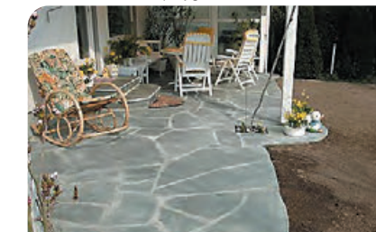
■ Komplettsanierung einer denkmalgeschützten Trockenbaumauer ■ Natursteinterrasse polygonal Verband
